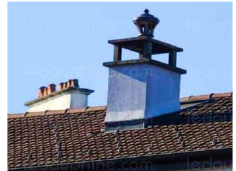
L'eau arrive de la chaufferie centrale de la ville, chauffée à 90 °C, avant d'être envoyée dans les étages par une pompe électrique. Chaque étage est desservi par un unique tuyau, qui serpente dans chacun des appartements, entraînant une répartition inégale de la chaleur. Photo illustration Le DL / T. P. V. S.
